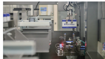
全工程を自動化した工場内部
