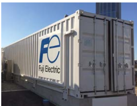
40フィートコンテナ外観
